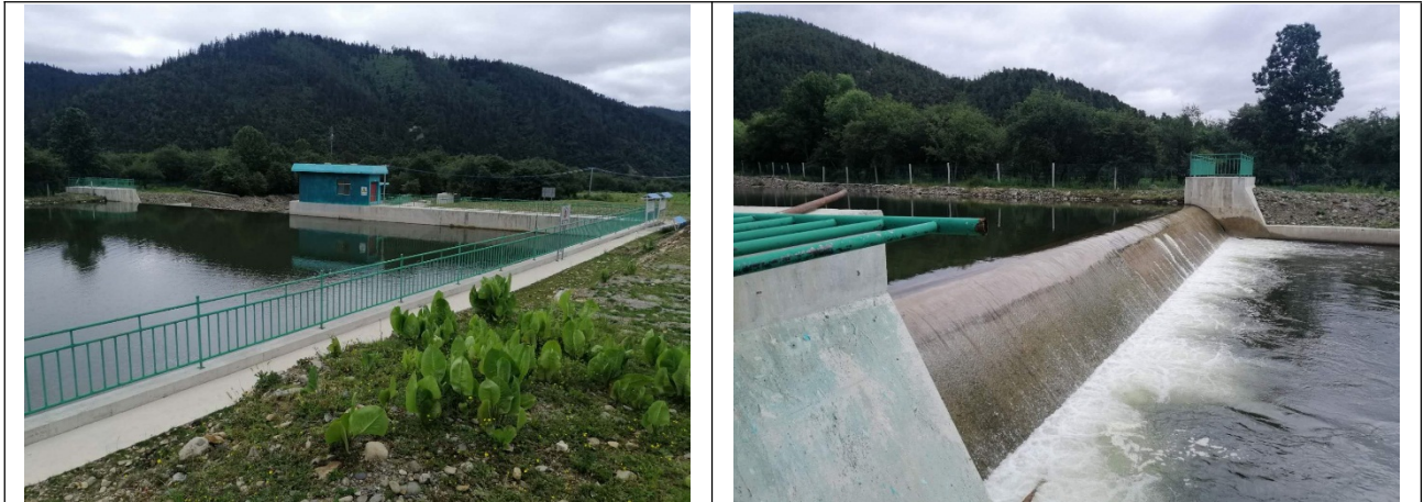
补水工程取水坝现状图
